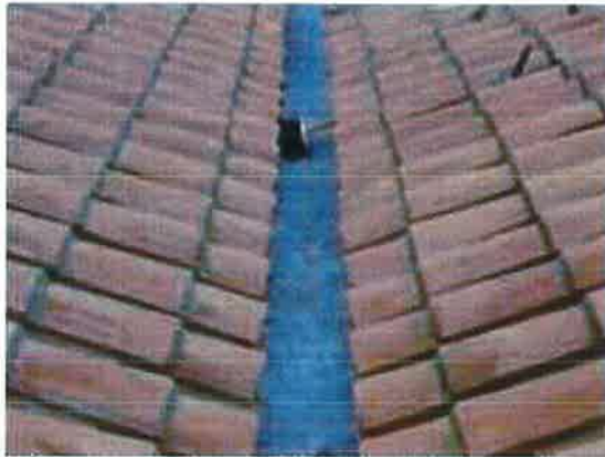
Fig. 3.17. Dettaglio del nuovo manto di copertura in coppi in prossimità del compendio fra le falde.
